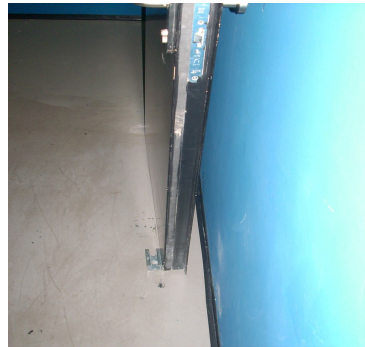
5. sz. kép: Tűzgátló ajtó kitámasztás padlóba lefűrt rögzítő elemmel
