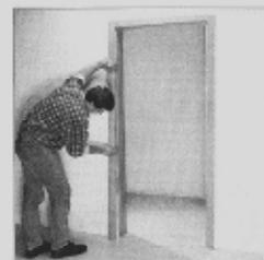
**9** A már előszerelést csaburkolatot a beépített tok homályába toljuk. A 20 mm-re eltolható csaburkolatot figyelembe a különböző falvastagságokat.
