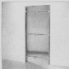
**6** A keret pontos elhelyezkedése érdekében három feszítőt csatlakoztatunk a függőleges keretrészek közé (pánt és zárméző magasságában).
