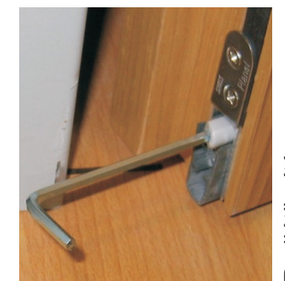
Látható tűzgátló önzáró szerkezet
