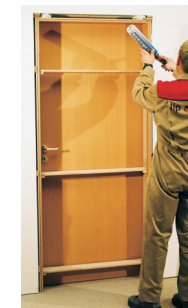
Tűzgátló PU hab alkalmazása
