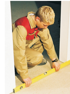
A padló vízszinteségének ellenőrzése
