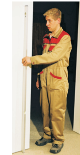
A függőlegesség ellenőrzése
