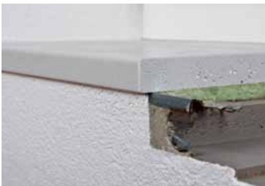
bündiger Einbau (mit Putzprofil)
