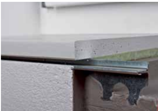
Einbau mit Schattennutprofil
